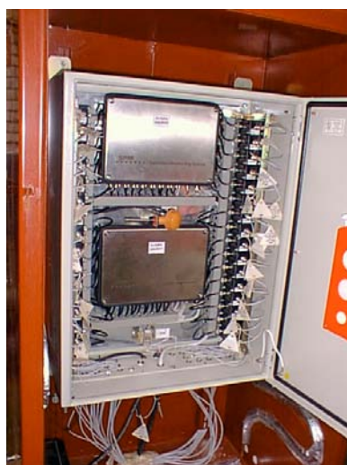
Рис. 10. Монтаж барьеров и измерительных блоков внутри шкафов.
